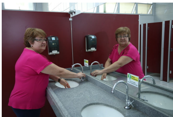
Figura 17 – Torneiras com redutores de pressão
