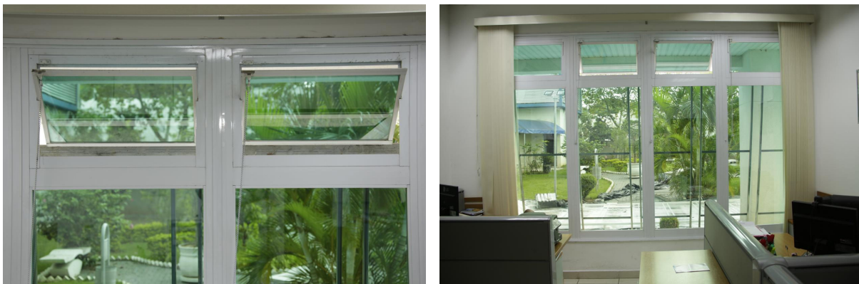
Figura 19 – Janelas com “bandeiras” (basculante)
